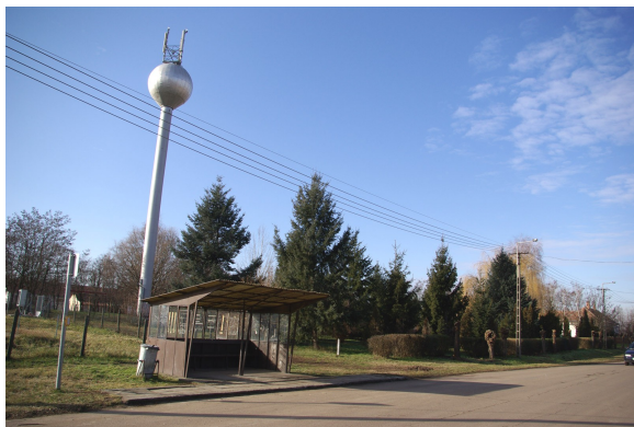
Felújításra váró buszmegálló.
